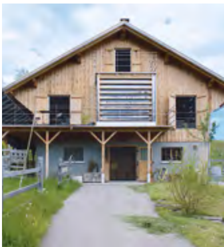
Das neue Ökonomiegebäude. Funktionale und zeitgenössische Architektur.
