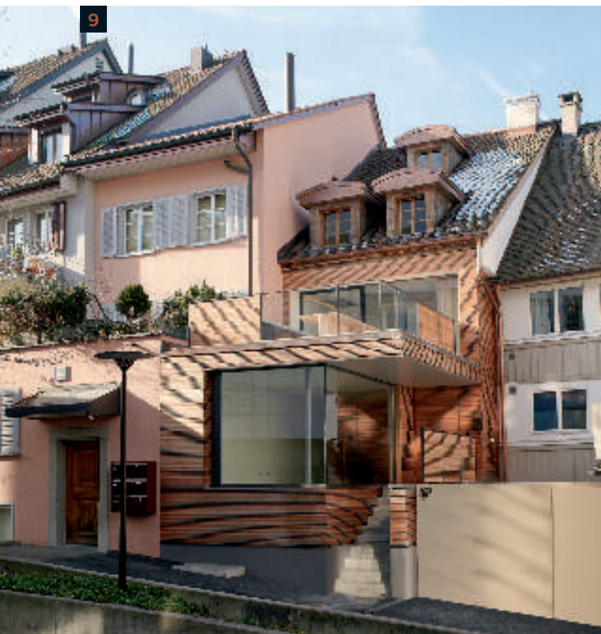
9: Auf der Stadtseite setzte Roger Stüssi dem Haus eine neue Fassade aus Lärchenholz vor.
